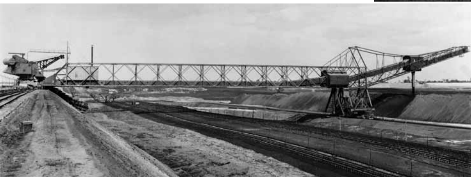
Abraumförderbrücke Laubusch im gleichnamigen Tagebau, um 1962
