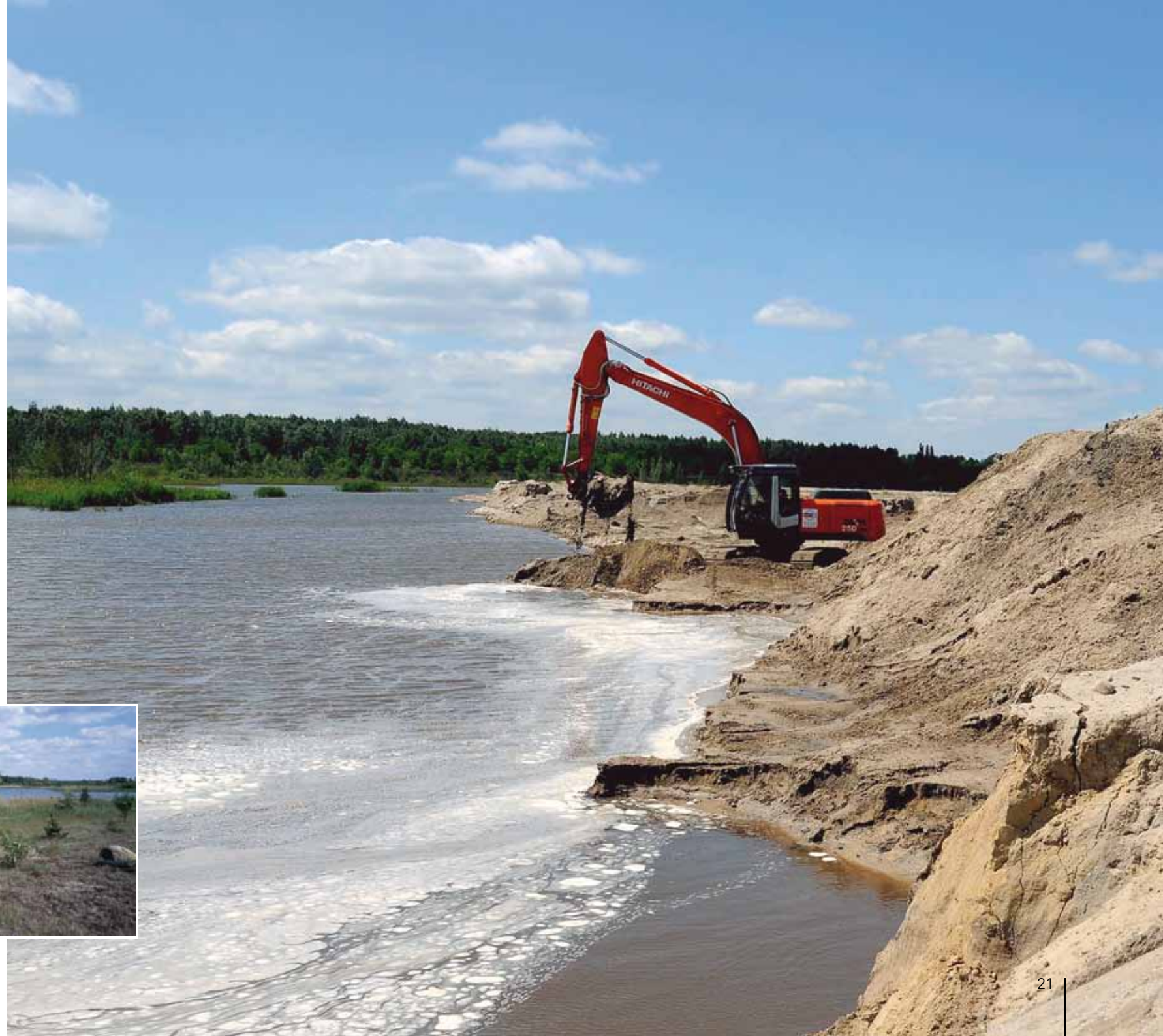
Böschungsarbeiten am Erika-See, 2009
