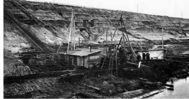
Senkung des Grundwasserspiegels durch Pumpen während des Neuaufschlusses des Tagebaus Erika, 1918
