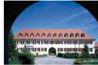
Saniertes Gebäude in der Gartenstadt Lauta-Nord, 2007
