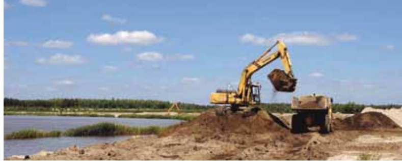
Erdarbeiten im Sanierungstagebau Laubusch, 2009
