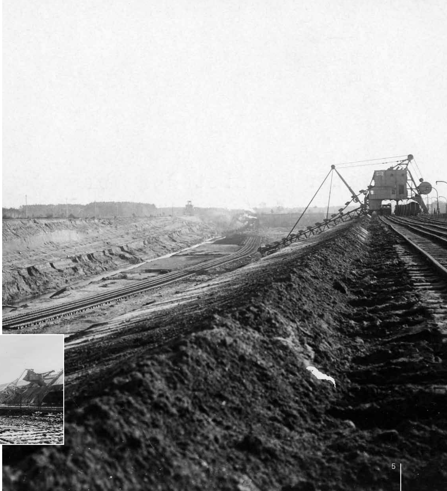
Erster Schnitt des Abraumbaggers während des Neuaufschlusses des Tagebaus Erika, 1918
