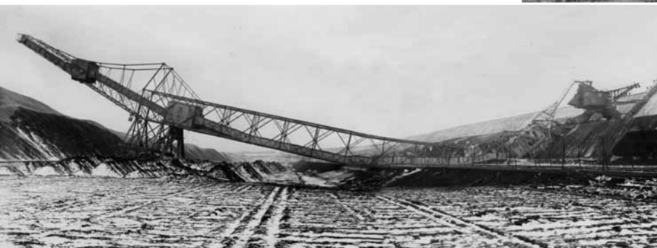
Eingestürzte Abraumförderbrücke im Tagebau Erika, 1937
