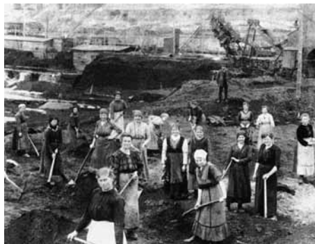
Putzkolonne beim „Nachputzen“ – manuelle Säuberung der Flözoberfläche von Abraumresten, 1925 „Weiße Brücke“ des Braunkohlewerkes „John Scheer“, 1954
